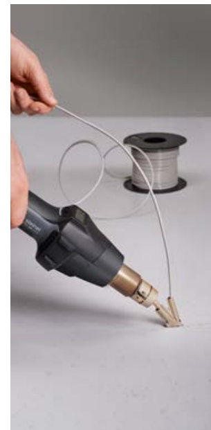
Saldatura del linoleum
