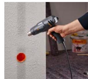
Asciugare l'intonaco
