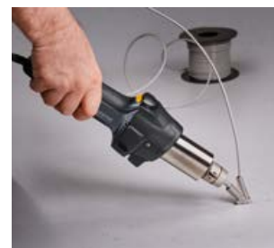
Saldatura del linoleum
